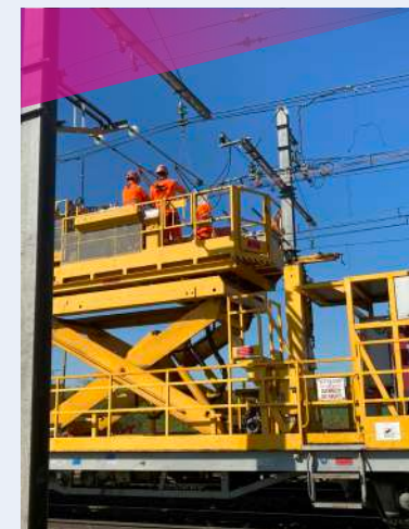
Intervention d'un « train dérouleur » sur l'axe Dijon - Saint-Amour en Saône-et-Loire.
